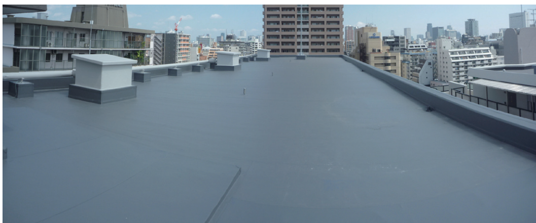
(工事後) 塩ビシートを敷き詰め、屋上全体をカバー
