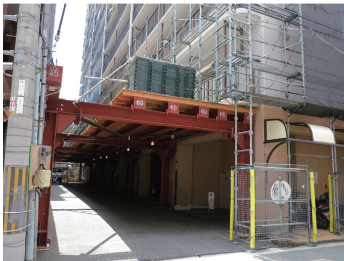
鉄骨の上に足場を組み、駐車場への出入り口を確保
