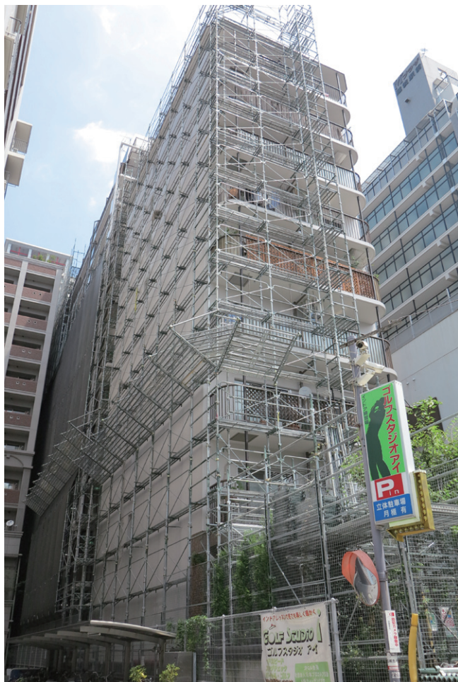
工事中の進和難波ハイライフ
