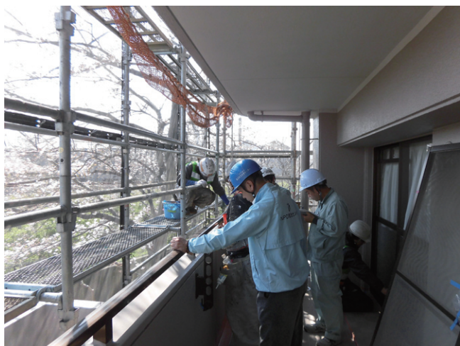
バルコニーの検査
