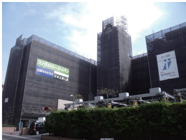
工事中の朝日プラザ南大和シティウエストウイング外観
