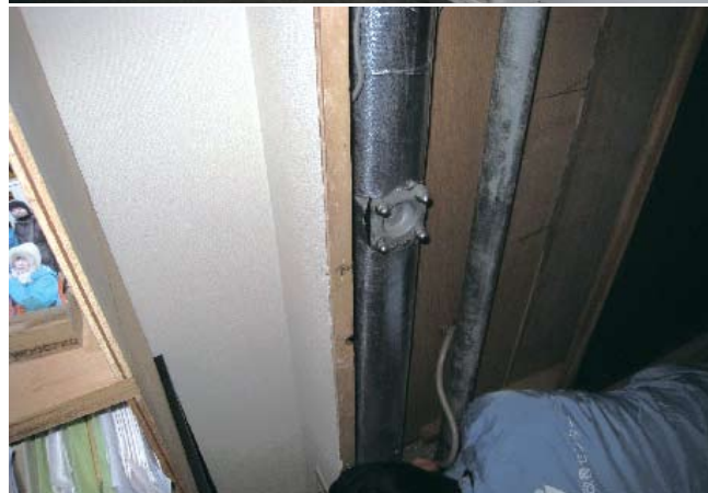
室内専有部分での工事箇所
