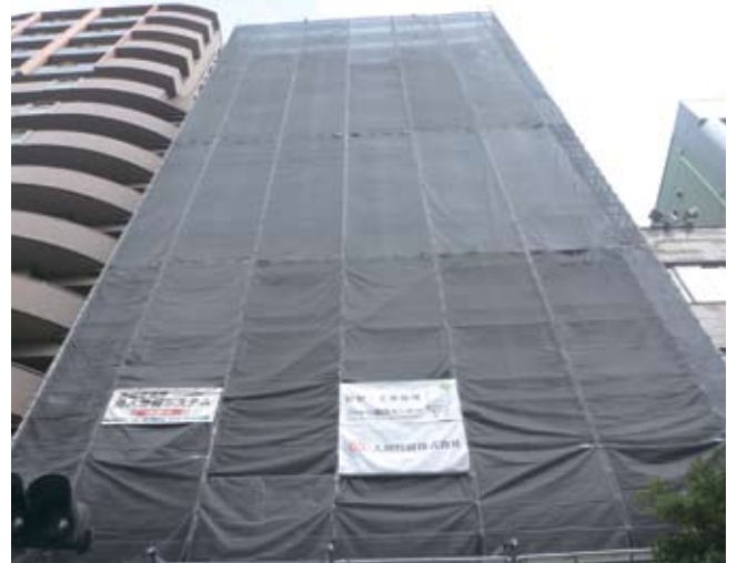
外壁の工事に着手
